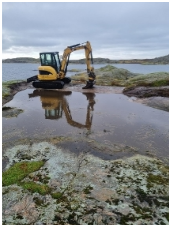
Det är inte alltid lätt att få en grävmaskin på plats för att restaurera hållkar på skärgårdsöar. Foto: Martin Sjöberg
