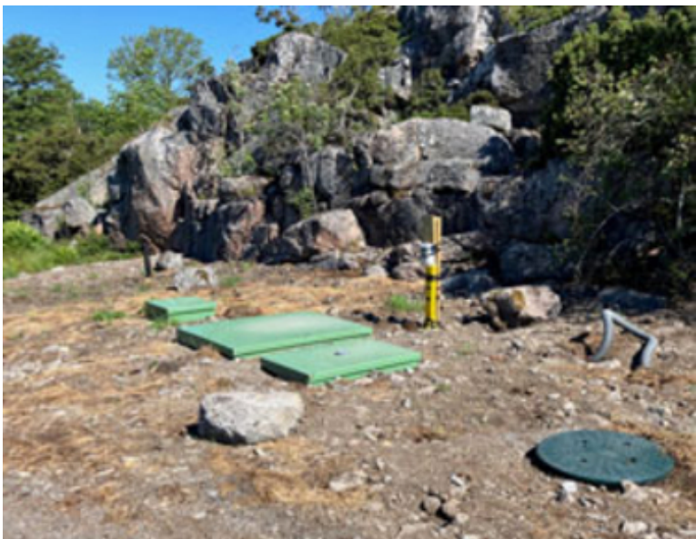
Endast locken syns på den nedgrävda avloppsanläggningen vid Rävängen. Foto: Länsstyrelsen.
